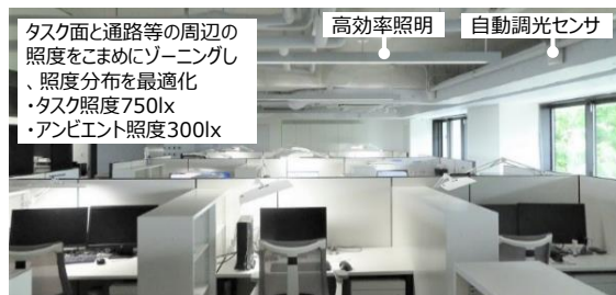
タスク・アンビエント照明空間と高効率照明、自動調光センサ
